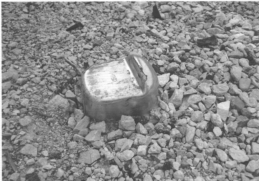
Particolare del battente d'arresto.
